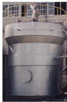
水酸化アルミ分離用結晶缶
